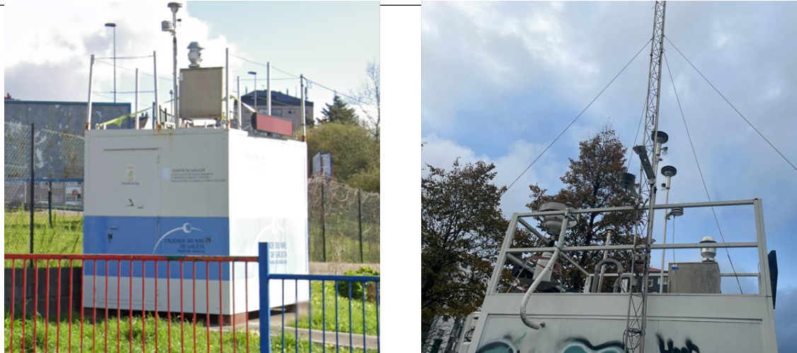
Figura 65: Estacións de calidade do aire de Lope de Vega e Coia. Fonte: Elaboración propia e Google Street View
